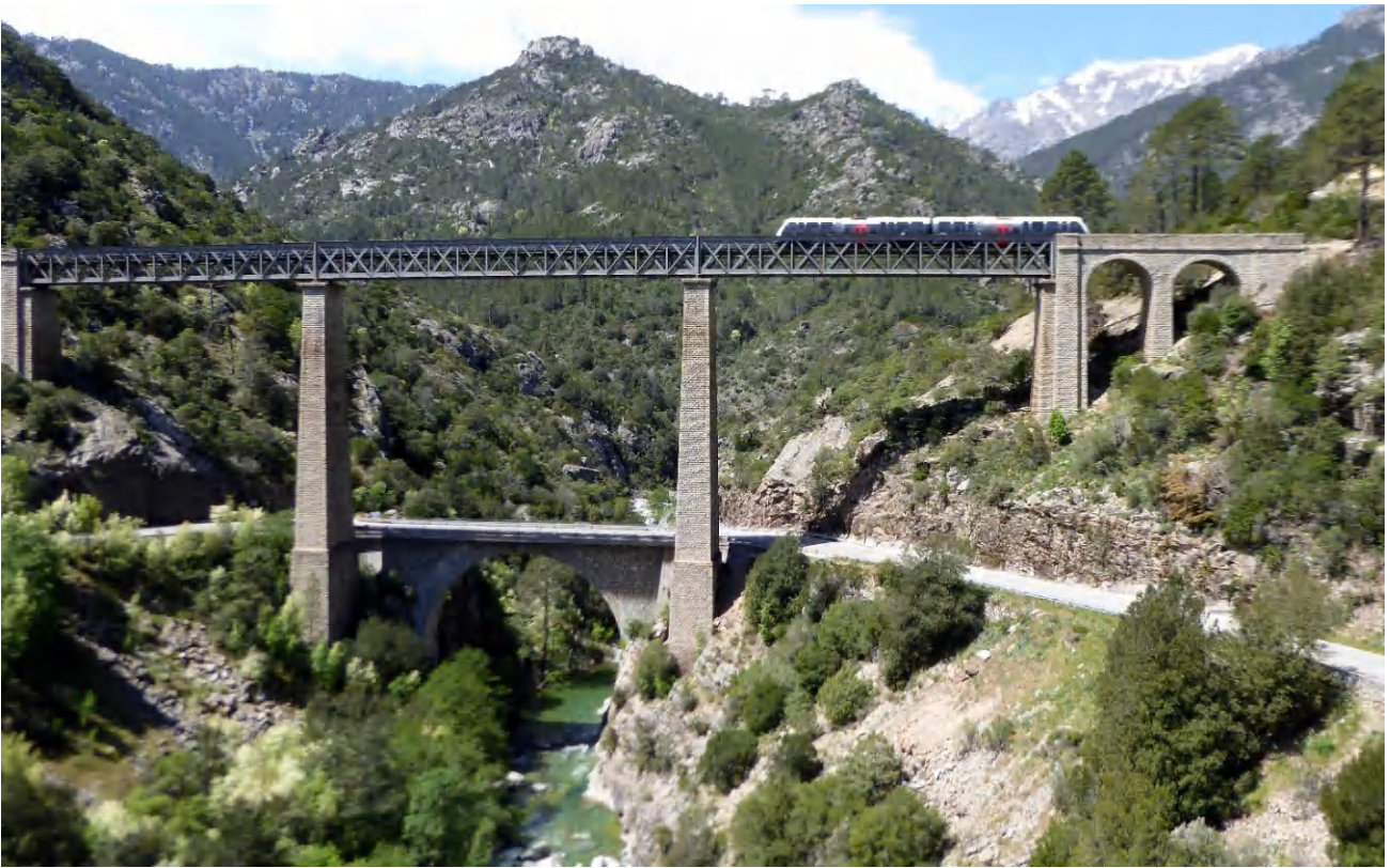
Vecchio-Viadukt, erbaut 1888 bis 1894 von Gustave Eiffel, dem Erbauer des Eiffelturms.
